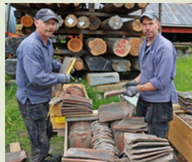
Gammel takstein i tegl fra depotet på Maihaugen skal benyttes på taket i den nye skostallen. Tom Egil Engen (til venstre) og Torbjørn Trygve Sund hadde en møysommelig jobb med å sortere ut takstein med rett høyde, bredde og profil.
