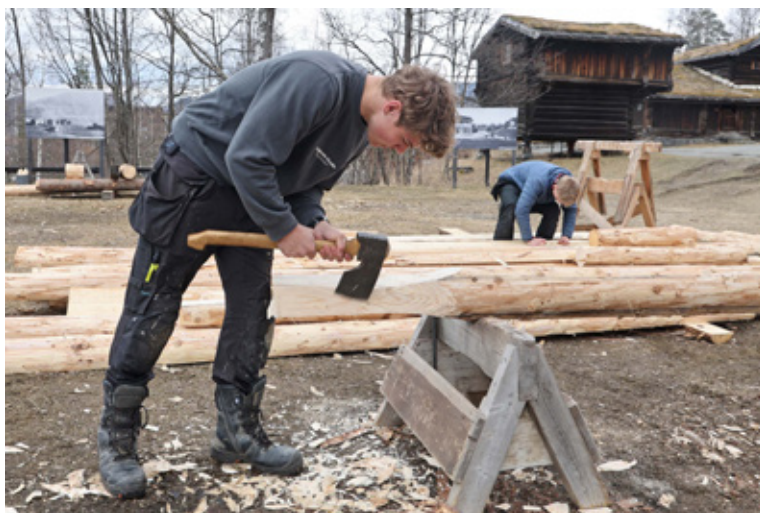
På dette kurset fikk Elias Porkka-Reiten prøve seg på nye teknikker, bl.a. å telje til tømmerstokker med øks og bile.
