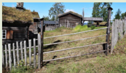
Det er flere slike grindle på Maihaugen med stolper som må skiftes etter en del år. Her er et slikt le ved Øygarden.
