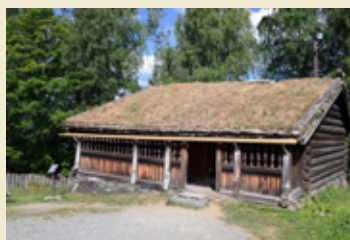
Takrenna ferdig montert på Årestua fra Tolstad
