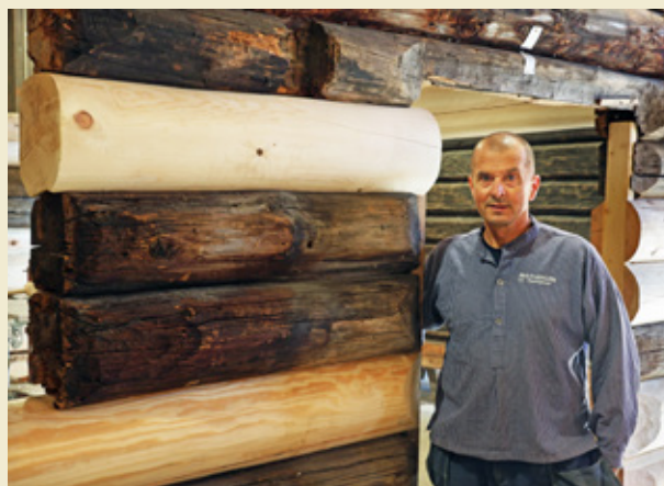
Vi prøver å rekonstruere de opprinnelige tømmerveggene så godt som mulig, bl.a teljer vi tømmerstokkene på innsiden, sier museumshåndverker Henning Svendsrud.
