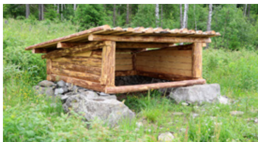
Slik ble grisehuset ferdig oppsatt.
