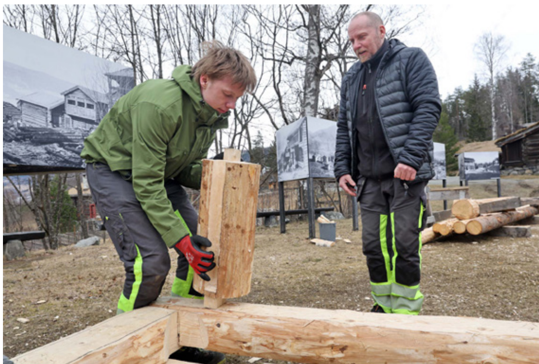
Eleven Lucas Eriksen prøver om tappen til hjørnestokken passer til hullet han har hogd ut i bunnsvilla. Faglærer Per Christian Moen overvåker det hele.
