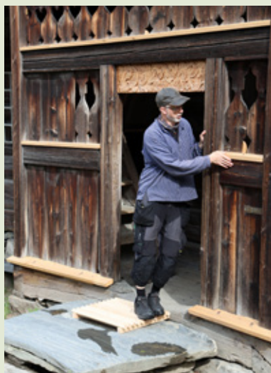
Jens Kåre Hole viser fram de nye vannbrettene som er på plass rundt inngangspartiet til Kårbygningen i Bjørnstadtunet.
