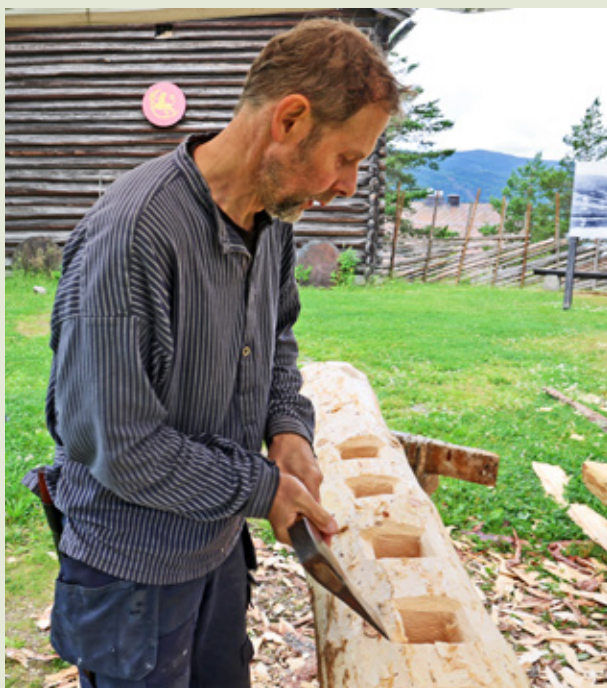
Museumshåndverker Terje Myhre lager nye stolper til grindle som skal skiftes ut med stolper som har råtnet.
